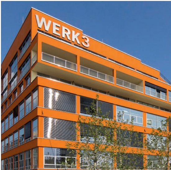
Putz und Metall – Die Fassadengestaltung von WERK3 orientiert sich am Gestaltleitfaden für das Werksviertel. © EVENTFABRIK München GmbH, Ivana Bilz
