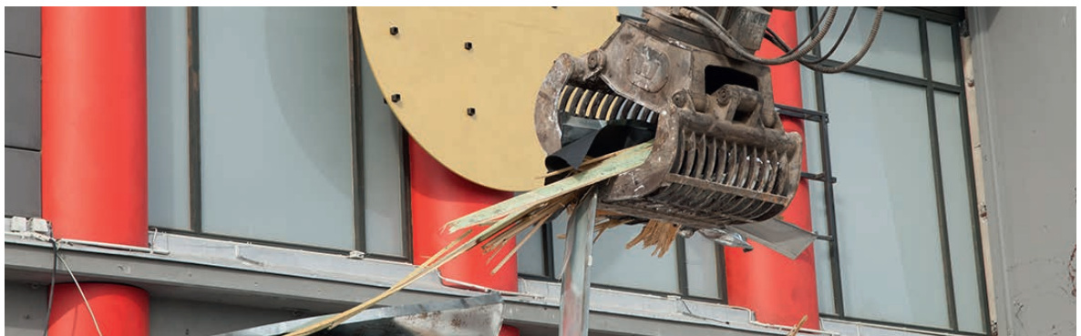
... zu den Abrissarbeiten am WERK2.
